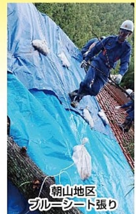
朝山地区ブルーシート張り
