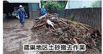
鳶巣地区土砂撤去作業
