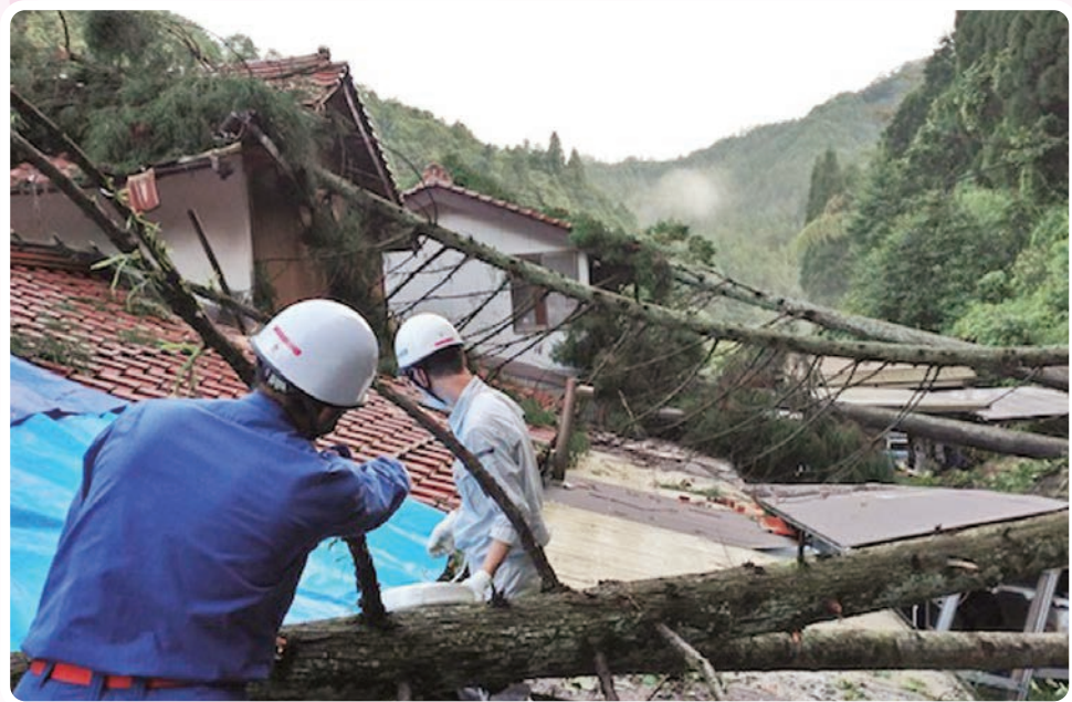
倒木被害を受けた 住宅への応急活動
