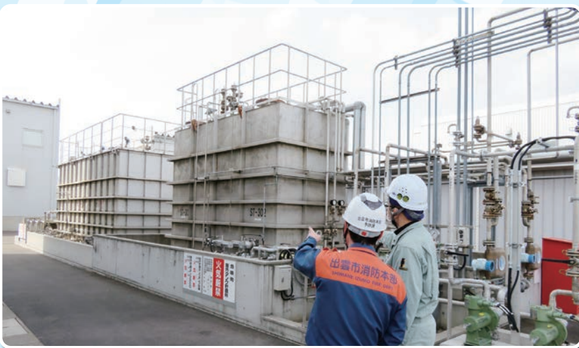
危険物貯蔵所 完成検査
