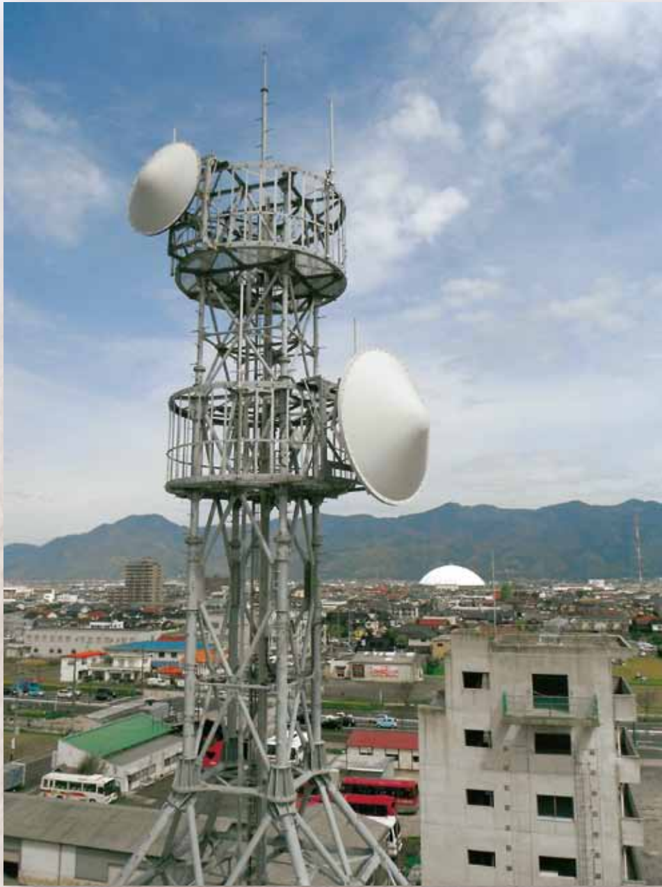
消防本部庁舎 無線塔
