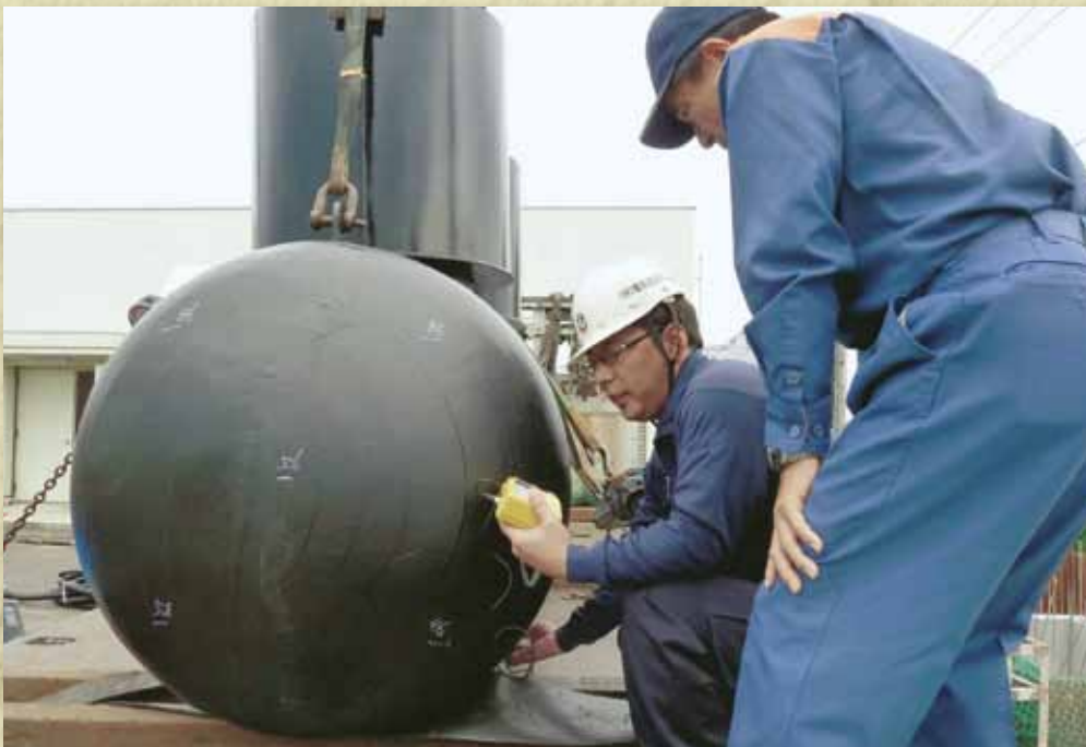
市内危険物施設 地下タンク検査
