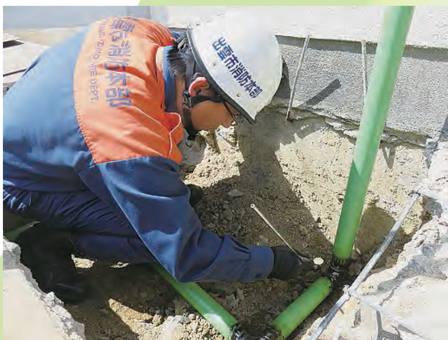
危険物施設 配管検査の様子
