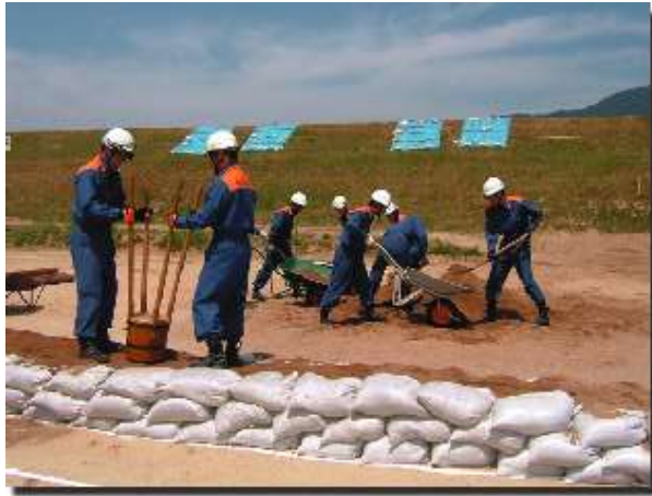
○土嚢作り及び土嚢積み訓練
