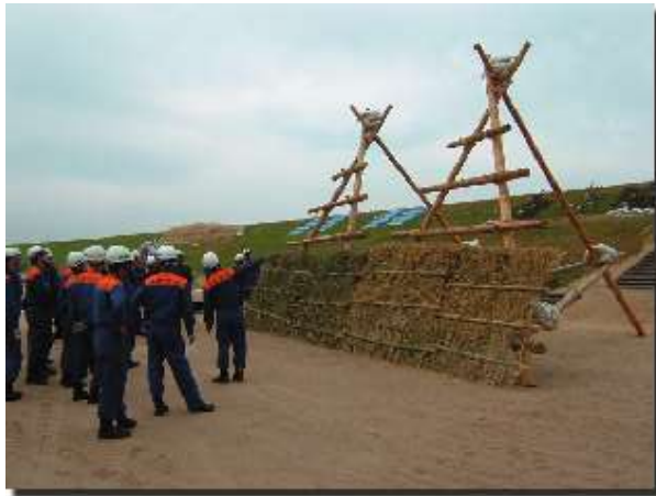
○出雲結い工全容 (竹壁前面に土嚢を積み水流から堤防決壊を防止する)
