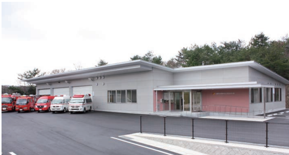
出雲西消防署庁舎竣工式・新庁舎全景
