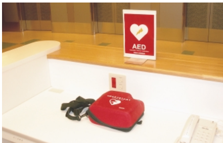
島根県立中央病院での設置状況 (各階のナースステーションに設置されています。)
