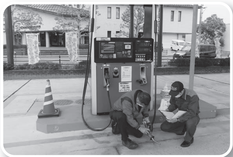
危険物給油取扱所 完成検査
