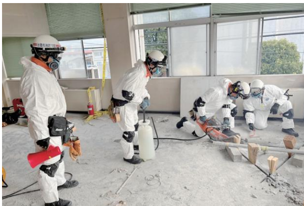
解体建物を使用したブリーチング（鉄筋コンクリート製の壁や床を破壊すること）訓練
